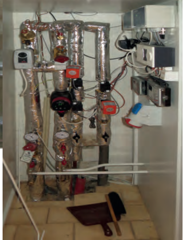
Her er et røntgebillede af, hvad der gemmer sig under gulvet - og "maskineriet", der styrer det.
